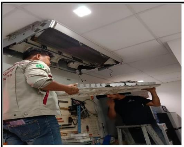
รูปที่ 3.23 ทำความสะอาดเครื่องปรับอากาศ
