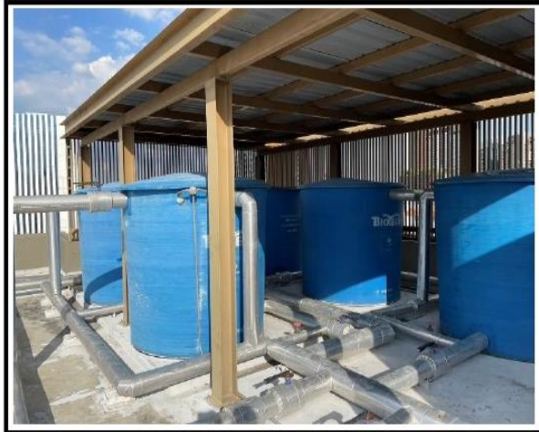
รูปที่ 3.13 ตรวจสอบถึงสำรองน้ำใช้และแนวท่อ
