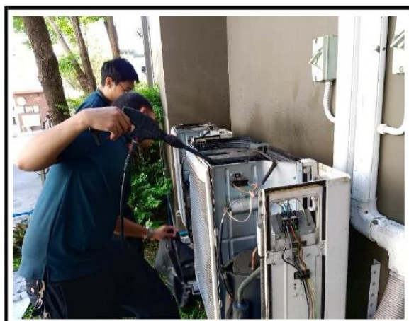
รูปที่ 2-58 ล้างทำความสะอาดคอนเดนสิ่ง
