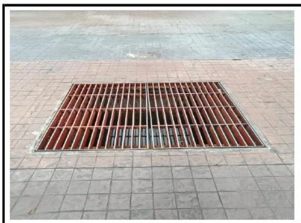
รูปที่ 2-15 ตะแกรงระบายน้ำดักเศษขยะ
