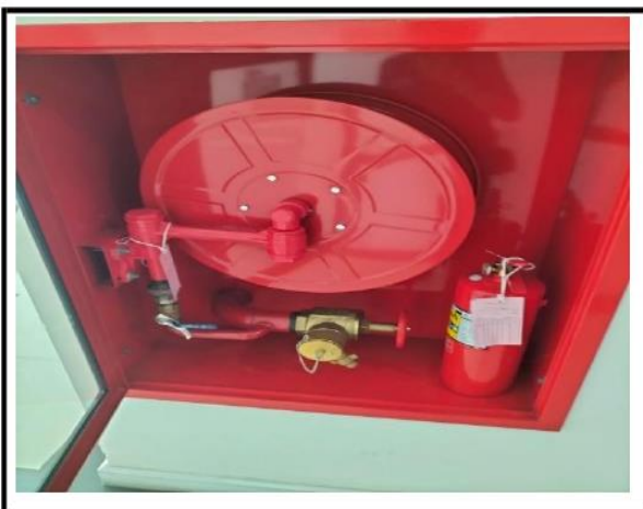
รูปที่ 2-43 ถังดับเพลิงเคมี
