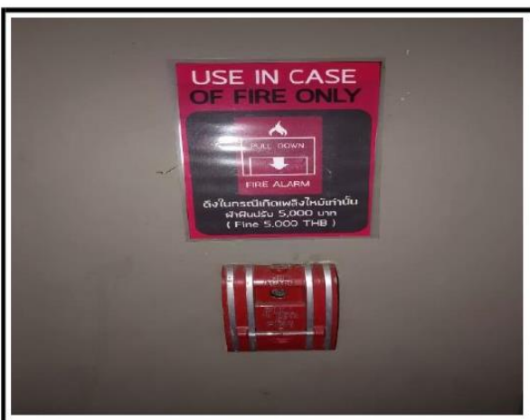
รูปที่ 2-47 อุปกรณ์ส่งสัญญาณเตือนภัย
