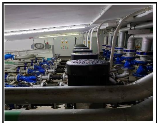
รูปที่ 3.18 Transfer pump
