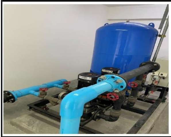
รูปที่ 3.19 Booster pump
